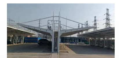
⊗ 光储充（换）电站
