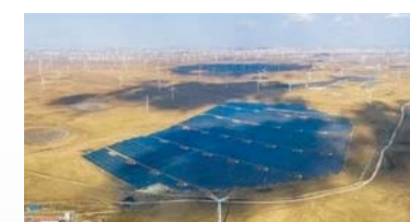
⊗ 中大型新能源电站（光伏、储能）
